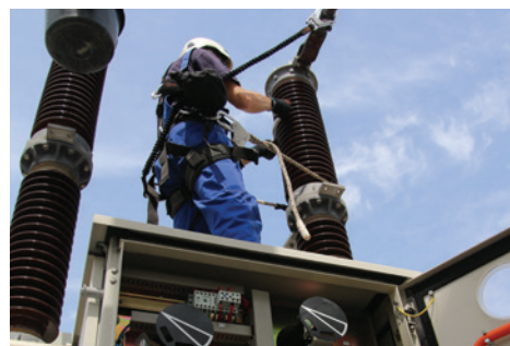
Manutenção da Subestação do Parque Eólico do Carreço Substation Maintenance - Carreço-Outeiro Wind Farm
